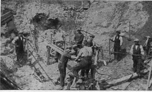
Fig. 21. Ramning af Sprøjterør.
